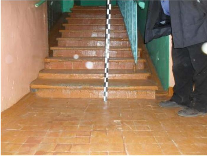
Фото №21 Запасный выход ступеньки с разными высотами
